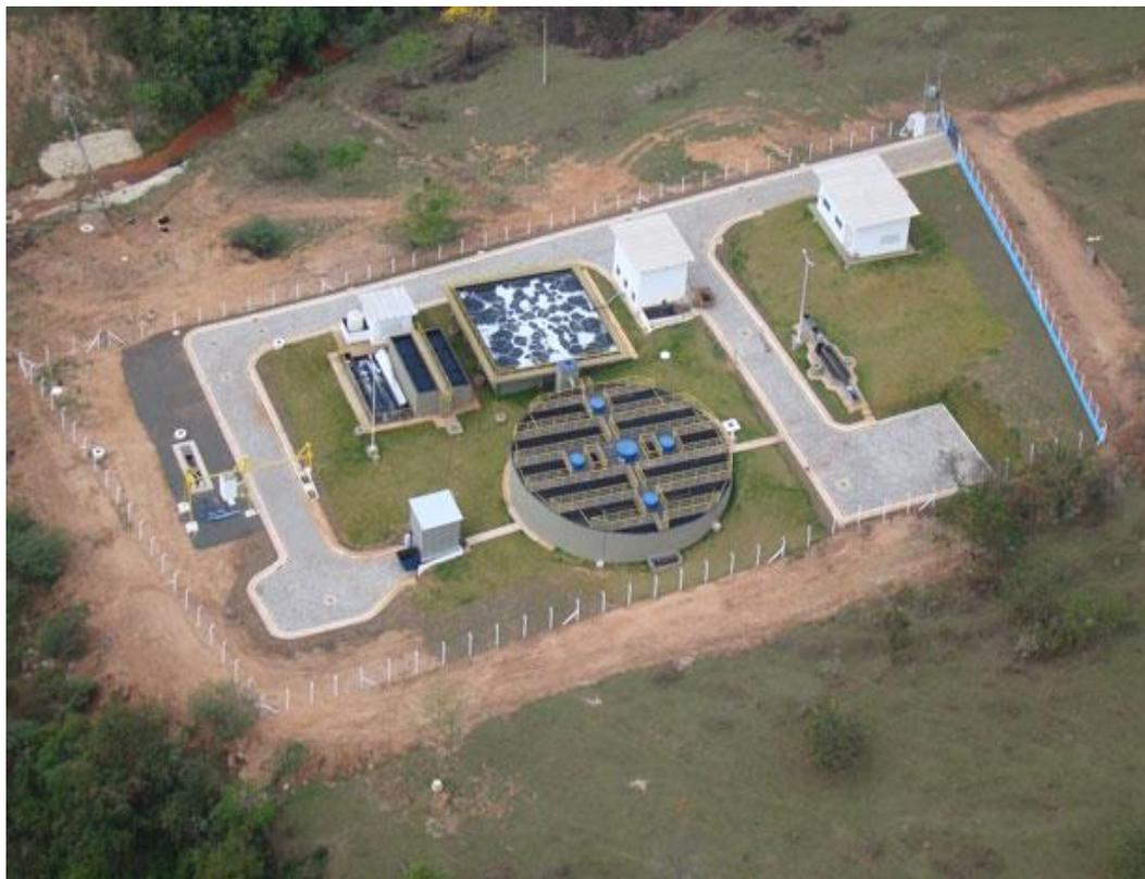
**Figura 106: Tanque de contato**
