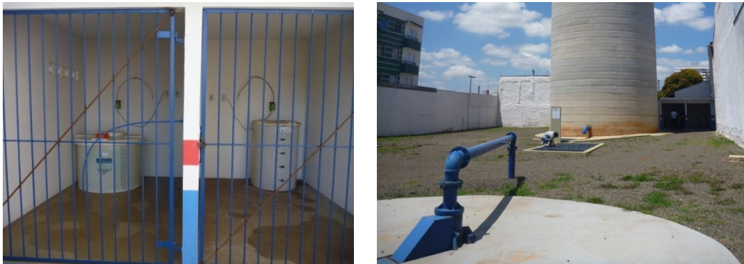
Figura 9.1 – Sistema de armazenamento, dosagem e aplicação de produtos químicos na UP 49 Cardia
