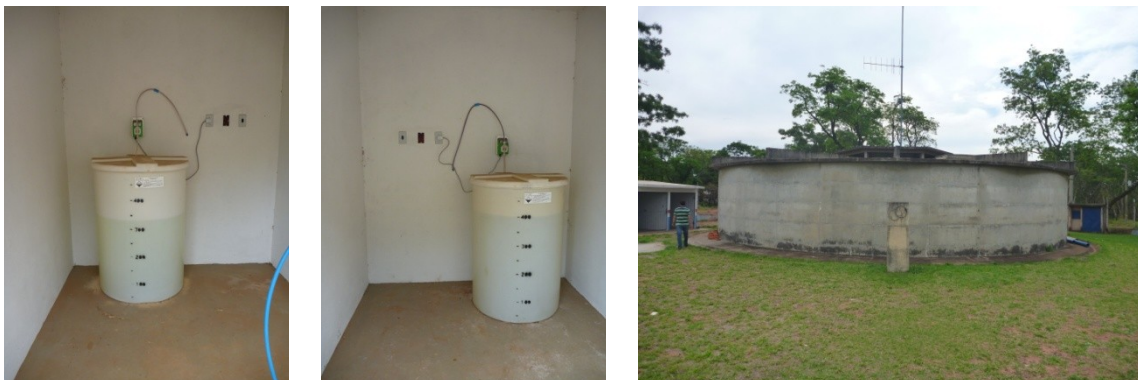
Figura 9.2 - Sistema de armazenamento, dosagem e aplicação de produtos químicos na UR 35 Santos Dummont
