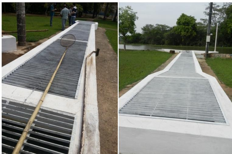
Figura 5.13 – Canal de veiculação de água bruta da lagoa ao poço de sucção
