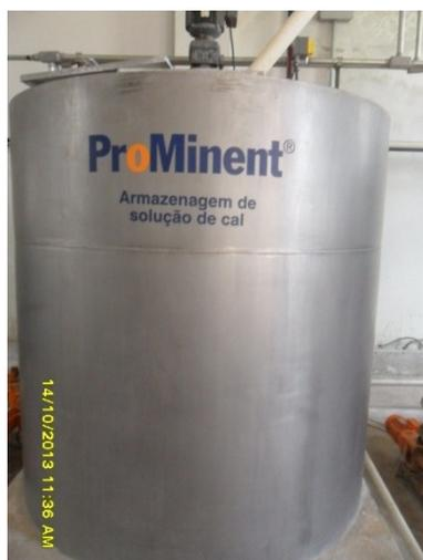
Figura 5.87 –Tanque de armazenagem da suspensão de cal – 1º piso da ETA
