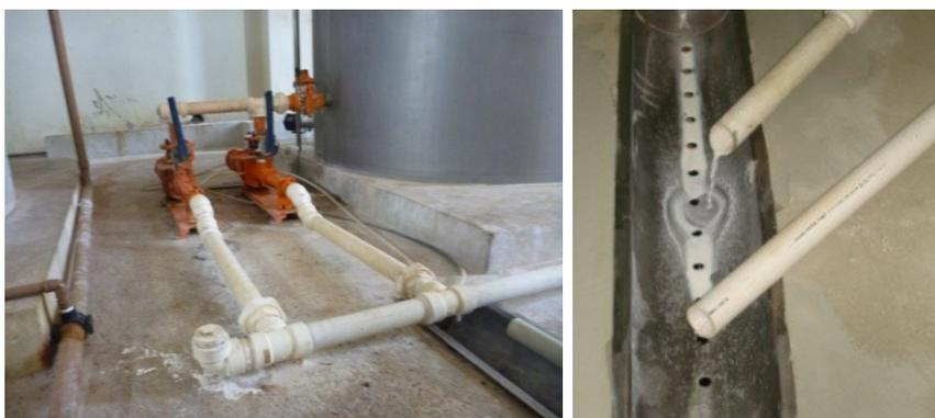
Figura 5.90 – Bombas dosadoras de cal na no 1º piso da ETA e meia cana de aplicação
