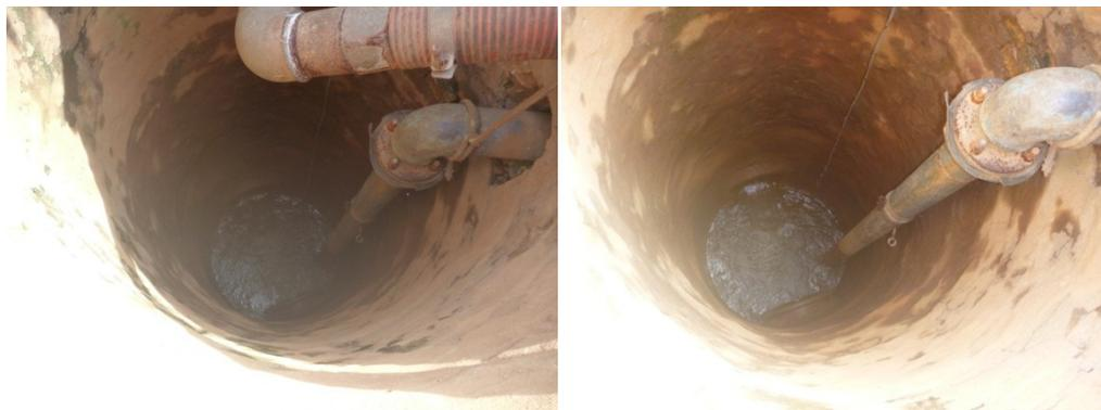
Figura 5.100 – Poço de retorno
