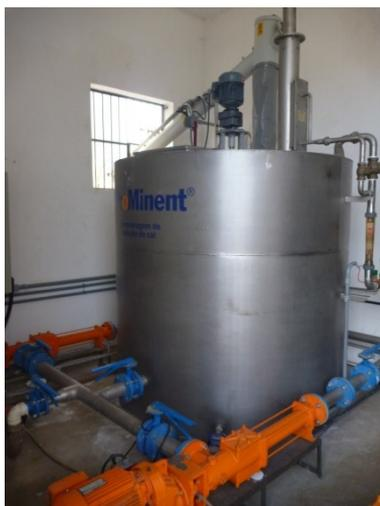
Figura 5.86 – Tanque de preparo da suspensão de cal – Sala de Controle e Preparo
