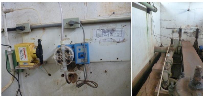
Figura 5.97 – Bombas dosadoras e tubulação de aplicação de ortopolifosfato de sódio
