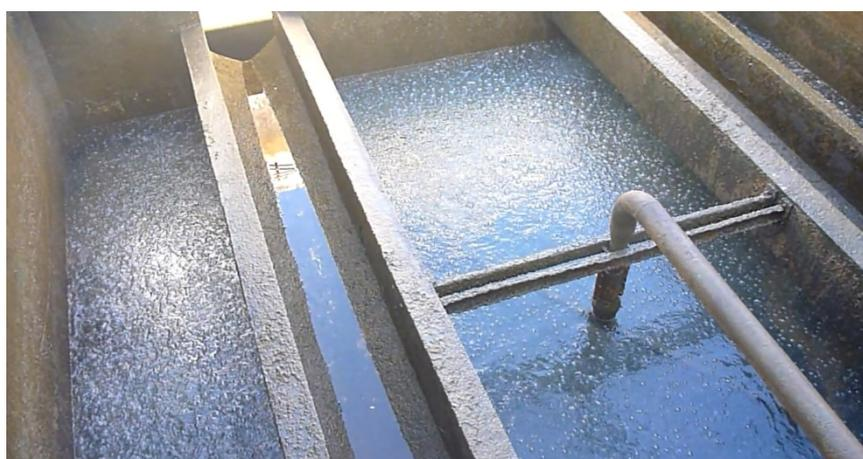
Figura 5.111 – Liberação de ar nos filtros após fechar a válvula de saída de água filtrada após carreira de filtração de 11 h
