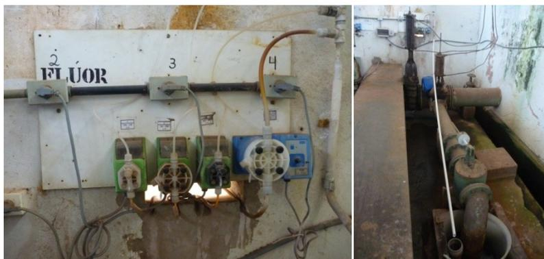
Figura 5.93 – Bombas dosadoras de ácido fluossilícico e local de aplicação
