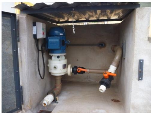
Figura 5.77 – Instalação de bombeamento do PAC ao reservatório de armazenamento
