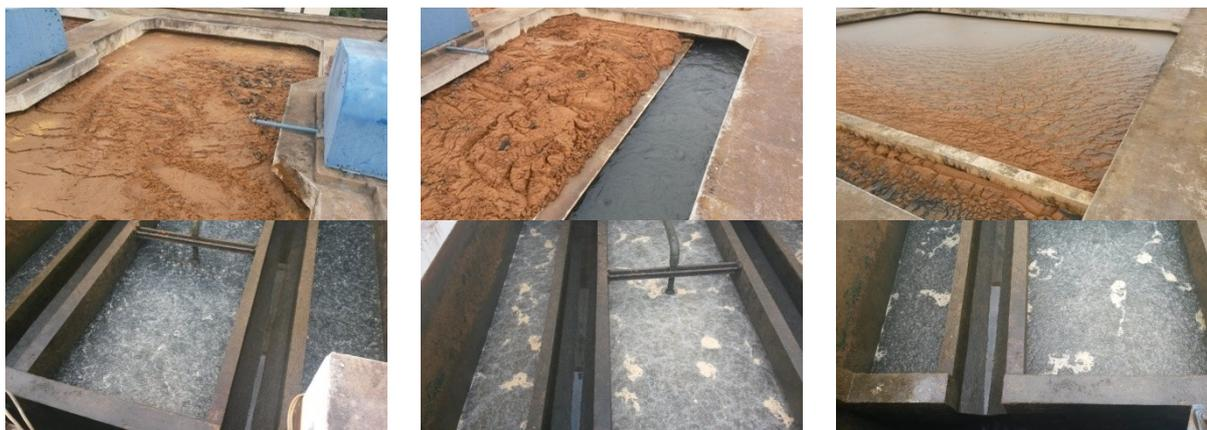
Figura 5.104 – Escuma acumulada nos floculadores e decantadores e liberação de ar retido nos filtros
