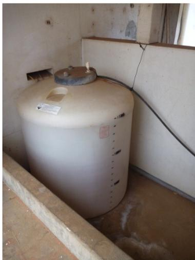
Figura 5.92 – Tanque de transferência para dosagem e aplicação de ácido fluossilícico na ETA
