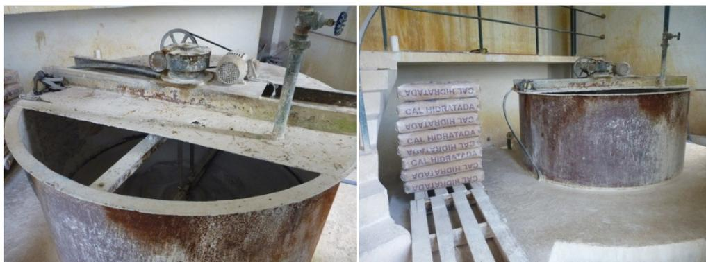
Figura 5.89 – Tanque de preparo de suspensão concentrada de cal hidratada
