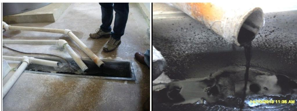
Figura 5.84 – Aplicação da suspensão de carvão ativado
