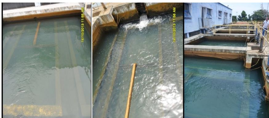
Figura 5.43 – Filtro em operação (a: entrada afogada; b: entrada livre; c: bateria de filtros)
