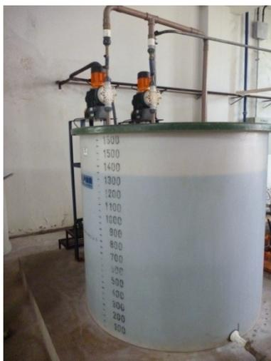
Figura 5.79 – Tanque de recepção para dosagem e bombas dosadoras de PAC
