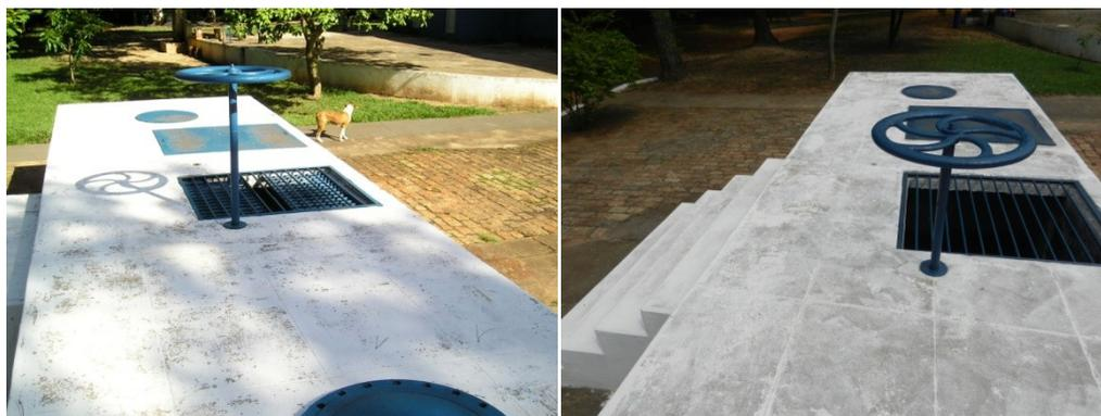
Figura 5.14 – Caixa de manobra na captação do rio Batalha
