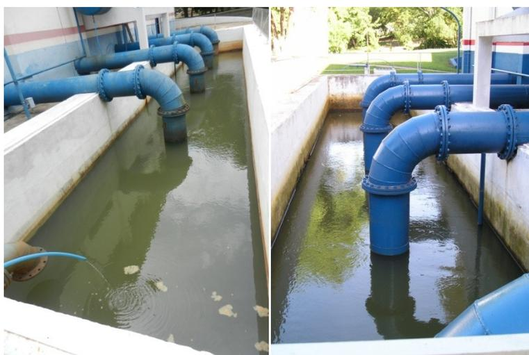
Figura 5.16 – Poço de sucção da estação elevatória de água bruta
