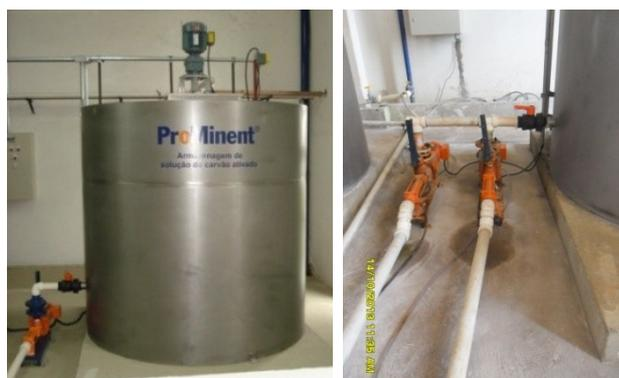
Figura 5.83 - Tanque de diluição de suspensão de CAP e bombas dosadoras (1<sup>o</sup> piso da ETA)
