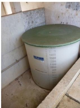
Figura 5.96 – Tanque de transferência de ortopolifosfato de sódio
