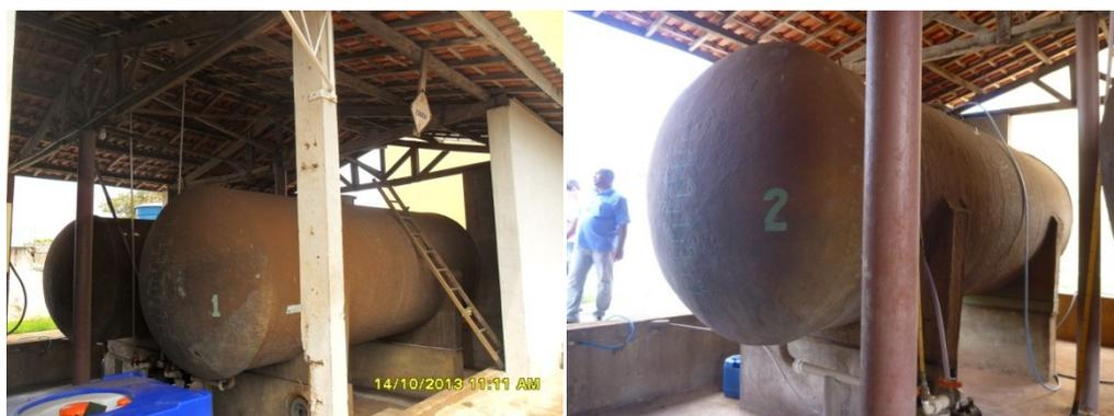
Figura 5.91 - Tanques de armazenamento de ácido fluossilícico
