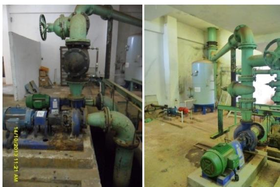
Figura 5.49 - Bombas de recalque de água para o reservatório elevado
