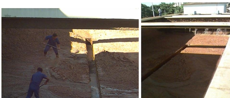
Figura 5.41 - Limpeza de um decantador (Fonte: Arquivo da Hidrosan)
