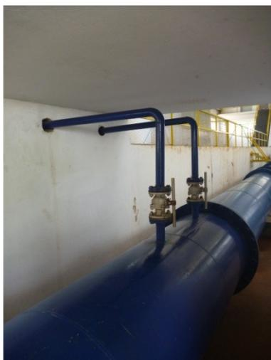
Figura 5.24 – Local de aplicação do dióxido de cloro na água bruta (adutora DN 800)
