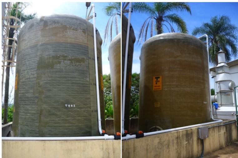
Figura 5.78 – Tanques de armazenamento de PAC
