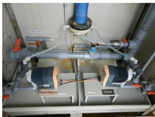
Figura 5.22 – Bombas dosadoras e reator para geração do dióxido de cloro
