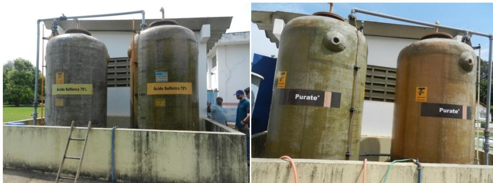
Figura 5.21 – Tanques de armazenamento dos reagentes para geração de dióxido de cloro - ácido sulfúrico 78% à esquerda e Purate à direita
