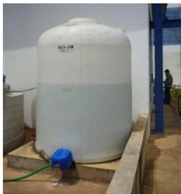
Figura 5.98 – Tanque de armazenamento de hidróxido de sódio para o lavador de gases
