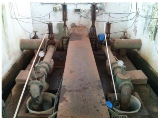
Figura 5.51 – Aplicação de ortopolifosfato (esquerda) e ácido fluossilícico (direita)
