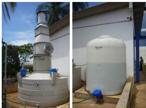
Figura 5.74 – Lavador de gases e armazenamento da solução de hidróxido de sódio
