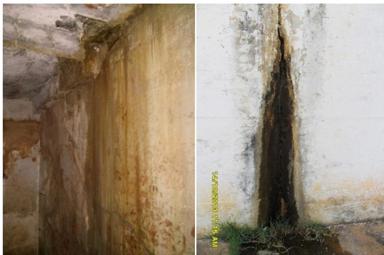
Figura 5.31 – Vazamentos observados na ETA sem recuperação da água (esquerda: laje inferior do canal de encaminhamento de água coagulada; direita: face externa da parede do decantador)
