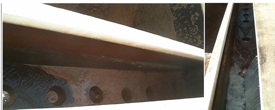
Figura 5.38 – Canal de distribuição de água no decantador
