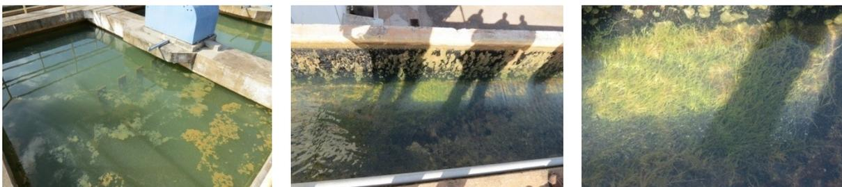
Figura 5.105 – Coloração esverdeada da água floculada e presença de macrófitas no canal de água coagulada
