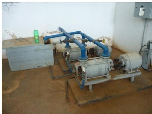
Figura 5.19 – Sistema de escorva das bombas da estação elevatória de água bruta
