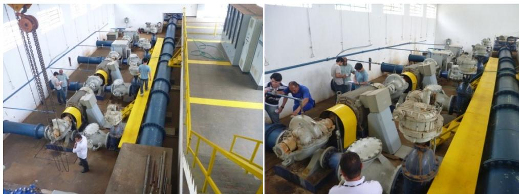
Figura 5.17 – Conjuntos motobombas da estação elevatória de água bruta
