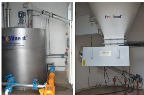
Figura 5.82 – Rosca transportadora e tanque de preparação de suspensão de CAP (Sala de Controle e Preparo)
