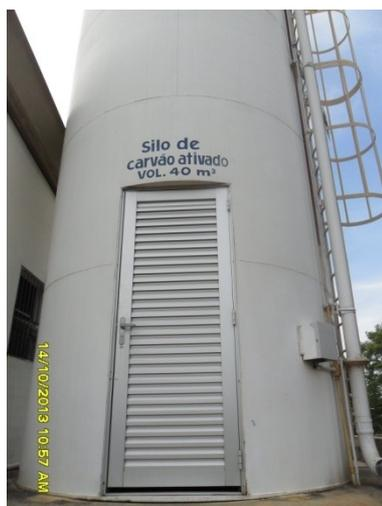
Figura 5.81 – Silo de armazenamento de carvão ativado pulverizado
