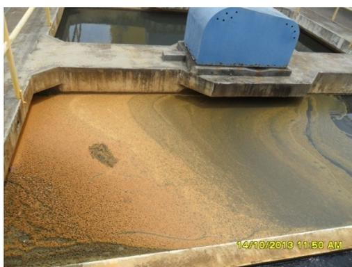
Figura 5.37 – Formação de espuma na câmara de floclação
