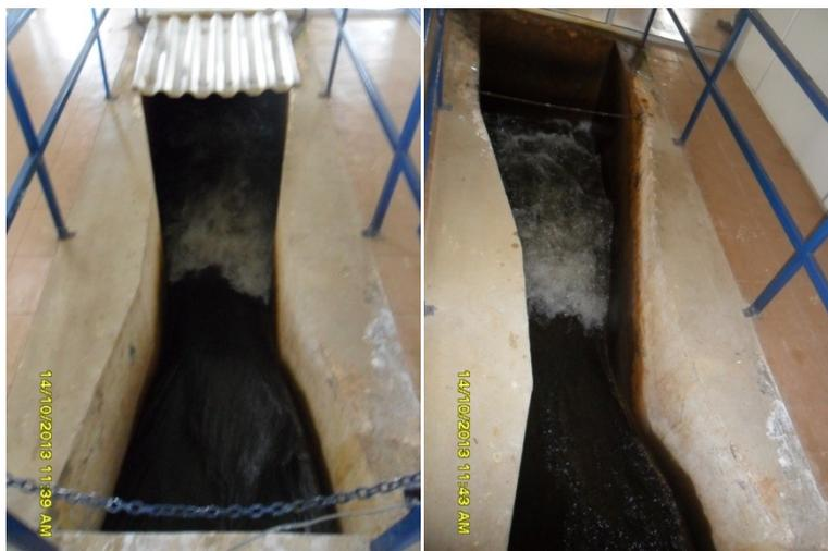
Figura 5.32 – Unidade de mistura rápida da ETA: Vertedor Parshall
