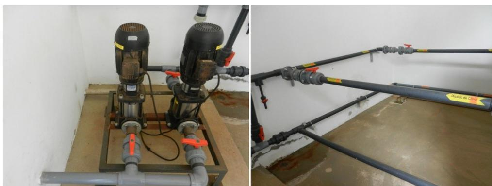
Figura 5.23 – Veiculação do dióxido de cloro na unidade de pré-oxidação da água bruta
