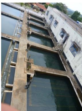
Figura 5.42 – Vista geral de uma bateria de 6 filtros
