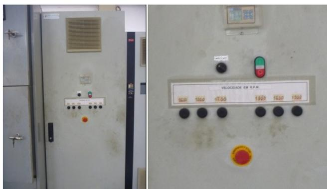
Figura 5.18 – Quadro de controle do inversor de frequência do conjunto B4 da estação elevatória de água bruta
