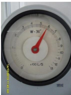
Figura 5.33 – Medidor de vazão da ETA
