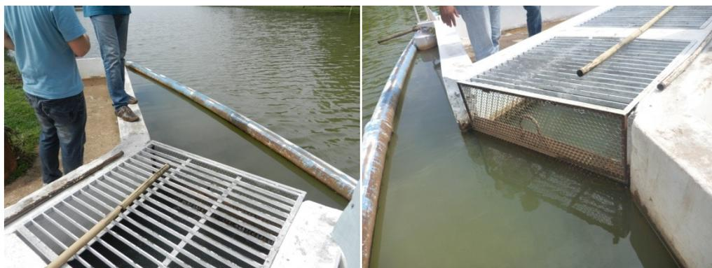
Figura 5.12 – Tomada de água do rio Batalha e gradeamento
