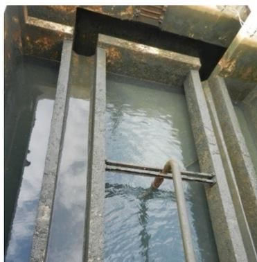
Figura 5.48 – Tubulação de alimentação do torniquete hidráulico para lavagem superficial do filtro
