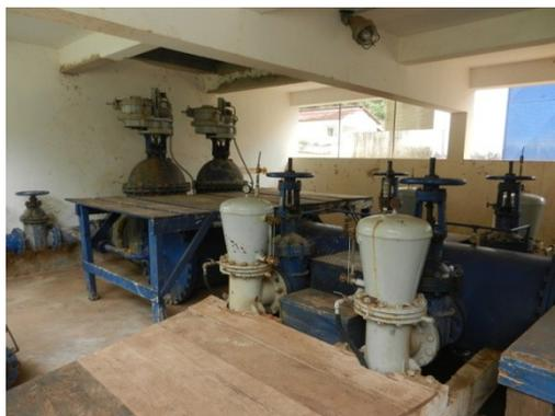
Figura 5.20 – Válvulas e registros da estação elevatória de água bruta
