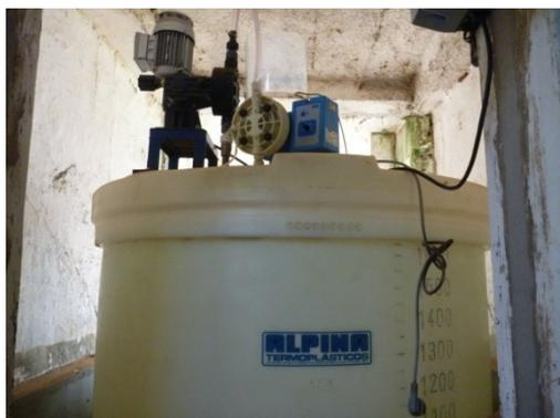
Figura 5.99 – Tanque de transferência de hidróxido de sódio e bomba dosadora para correção final de pH
