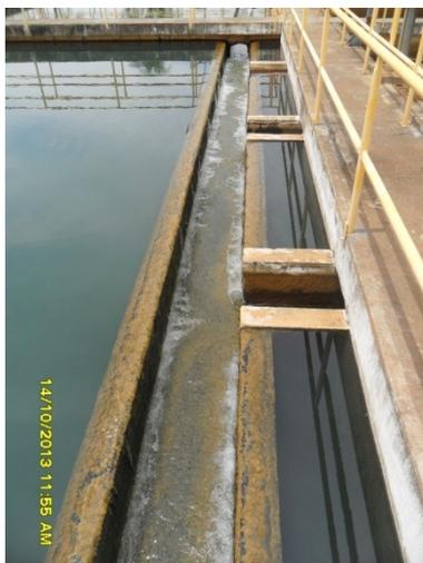
Figura 5.40 – Calha de coleta água decantada
