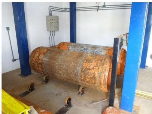
Figura 5.73 – Cilindros de armazenamento de cloro
